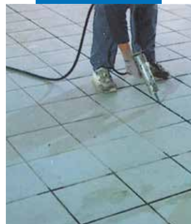
Keraamiliste põranda- plaatide tihendamine Mapesil AC-ga
