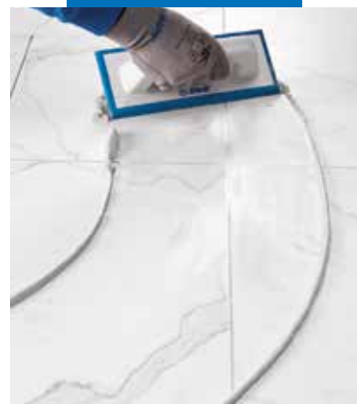
Ultracolor Plus paigaldamine põrandale kummist kelluga
