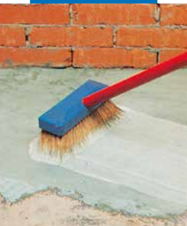
Planicrete lisandiga tsementkrohvi paigaldamine
