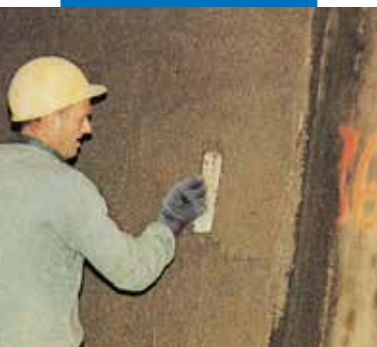
Planicrete lisandiga tsementkrohv – Ville Marie maanteetunnel, Montreal, Kanada
