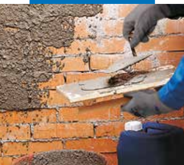
Planicrete lisandiga mördi aluskihi paigaldamine
