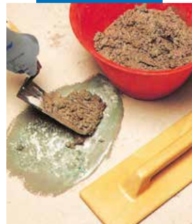
Põranda paikamine: mördi paigaldamine
