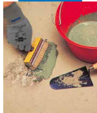
Põranda paikamine: nakkelobri paigaldamine
