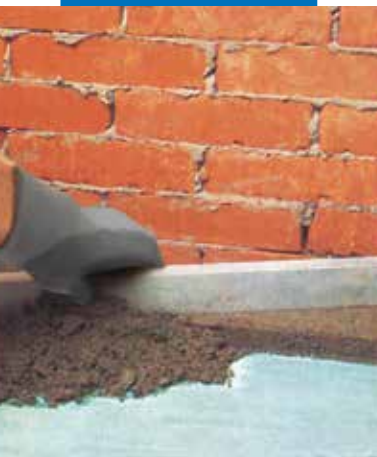
Planicrete lisandiga tsement-tasandussegu paigaldamine
