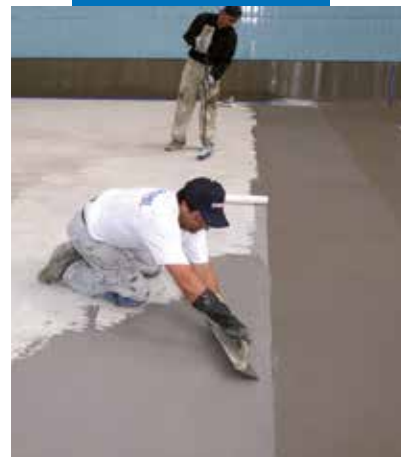
Ujumisbasseini hüdroisolatsioon Mapelasticu abil
