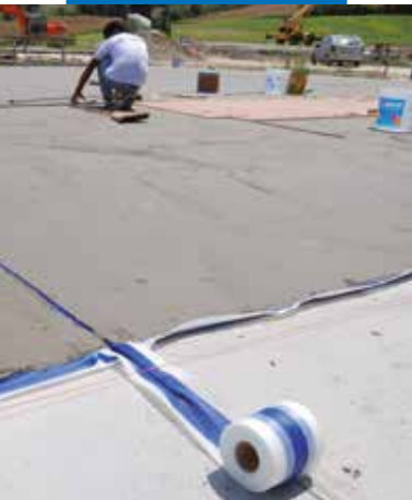
Hüdroisolatsioon Mapelastic ja Mapeband toodetega
