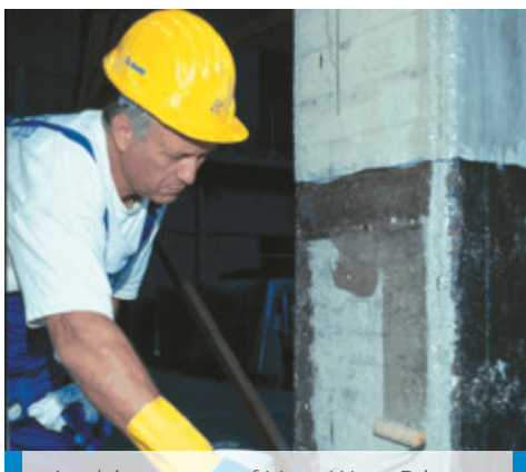
Applying a coat of MapeWrap Primer 1
